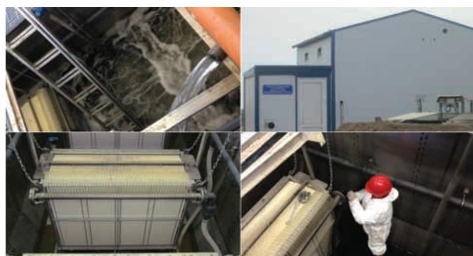
**1.** Хозяйственно-бытовые стоки поступают самотеком в резервуар-усреднитель для выравнивания расхода стока и концентрации загрязняющих веществ в сточной воде. Резервуар оборудуется насосной группой для напорной подачи стоков на станцию биологической очистки и поплавковым выключателем для автоматизации работы насосов.
